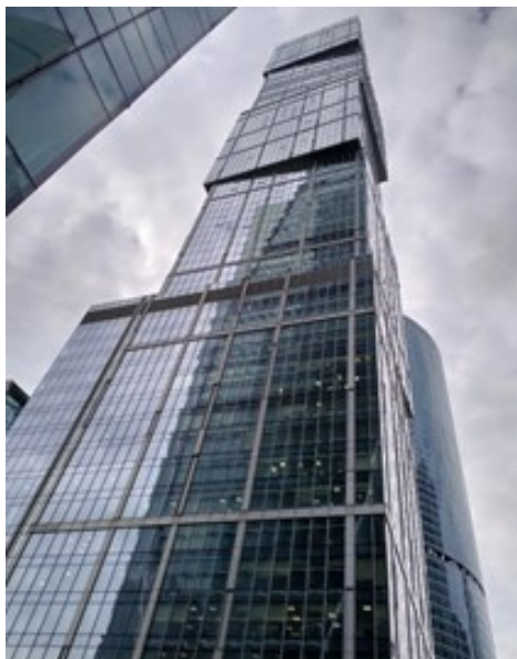
Рис. 5. Башня «Москва» комплекса «Город столиц», Москва-Сити (фото автора – Маяцкая И.А.)
